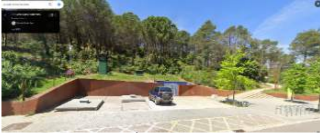
IMATGE ACTUAL DE L'ÀMBIT D'EQUIPAMENT OCUPAT PER LA CENTRAL DE CALOR AMB BIOMASSA. OBSERVI'S LA XEMENEIA QUE, TOT I QUE S'INTEGRA A LA VEGETACIÓ DEL PARC, NO FORMA PART D'AQUEST.
